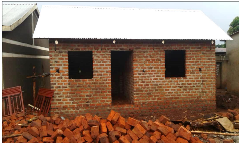
De bouw van het nieuwe huisje schiet al goed op...
